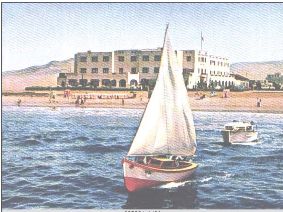
Figura N° 1. Vista de la zona de playa en el litoral de Chimbote frente al hotel de turistas en el año 1950, actualmente ha desaparecido y se encuentra protegido por defensas tipo enrocado.
